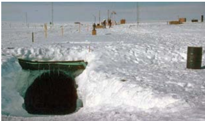
Рис. 4. Станция «Халли-3», построенная в 1973 году, была заброшена в 1983-м из-за проблем с доступом и вентиляцией
