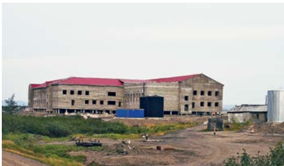
РИС. 2. НЕДОСТРОЕННОЕ ЗДАНИЕ ОБЩЕОБРАЗОВАТЕЛЬНОЙ ШКОЛЫ П. КЮСЮР
