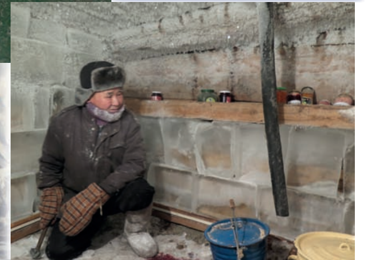
Ледник эвенков в пос. Сасыр. На правом рисунке виден чёрный шланг, ведущий наружу, чтобы охладить пространство ледника.
