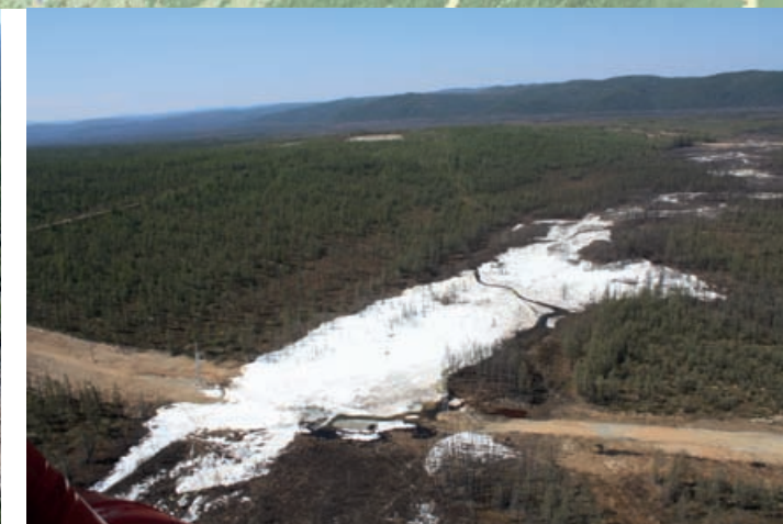
Наледь, пересекающая нефтепровод
