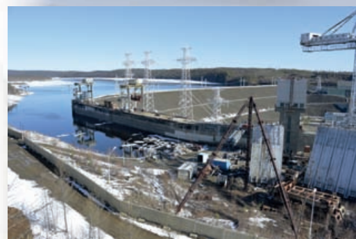
Дамба на Вилюйском водохранилище, состоящая из вечной мерзлоты, которая препятствует фильтрации воды
