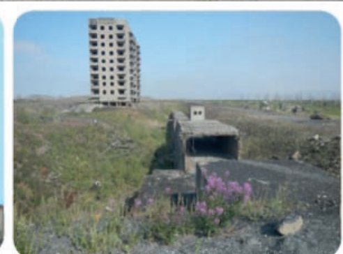
Подземный коллектор коммуникаций. Утечка тепла из таких коллекторов является одной из главных причин таяния мерзлоты в городах
