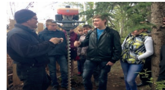
Бурение скважины в пос. Верхолениск
