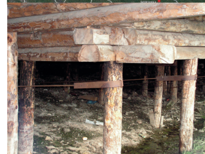
Свайный фундамент – один из способов охлаждения мерзлых грунтов под зданиями. Металлические тросовые стяжки предотвращают перекося свай
