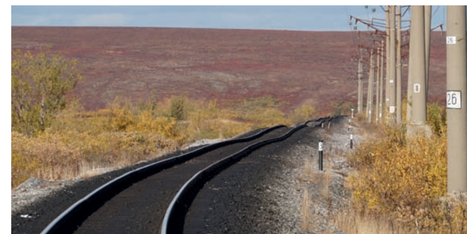
Деформации железнодорожного полотна близ станции Хановей
