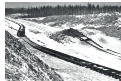
Наледи на железной дороге при строительстве БАМа
