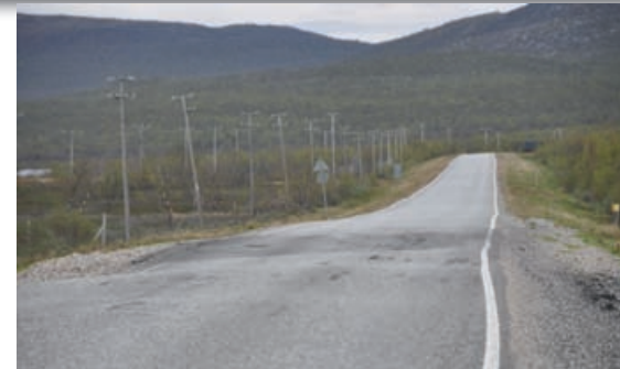
Дорога, пересекающая сильнольдистые породы, таяние которых деформирует полотно
