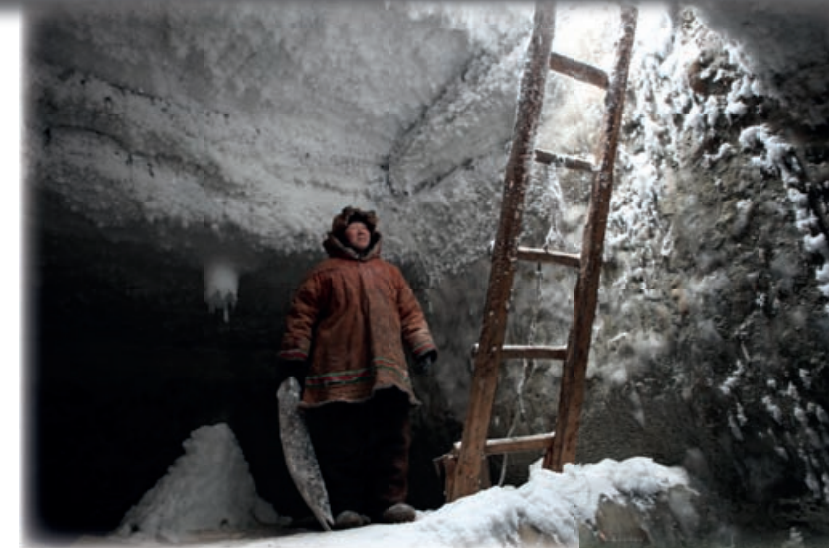
Ледник в пос. Андрюшкино. Юкагиры также используют вентиляцию холодным воздухом для эффективного охлаждения. Сзади человека видна небольшая вентиляционная труба
