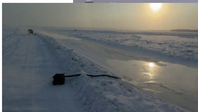
Обустройство ледяной дороги (зимника) через р. Лену. Насос закачивает речную воду на дорогу, чтобы сделать её поверхность гладкой
