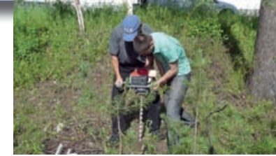
Бурение мониторинговой скважины в пос. Беркакит
