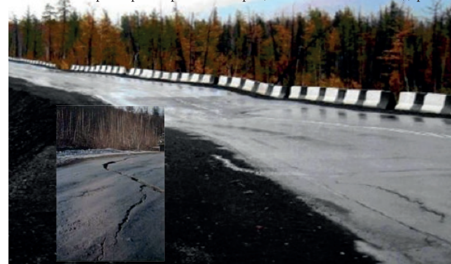
Термокарст и криогенные трещины на автомобильной дороге
