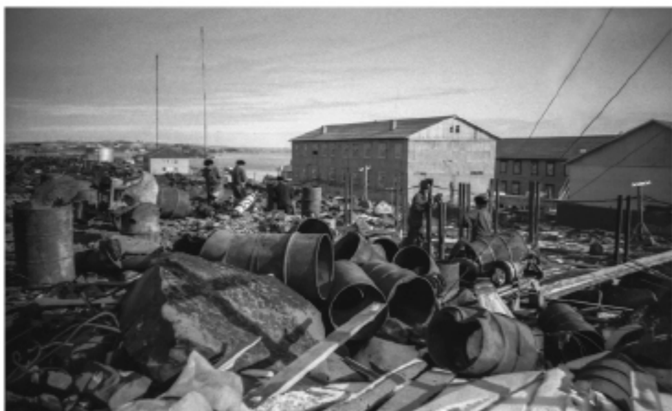
О. Диксон. Строительство нового здания Центра связи Диксонского УГКС.
