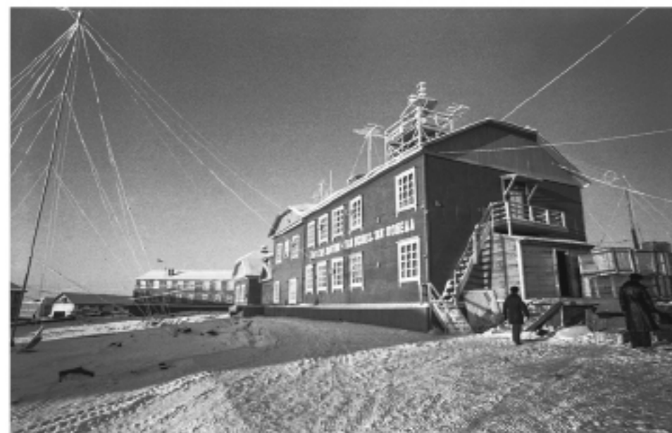
Территориальный центр связи Диксонского управления гидрометеослужбы.
