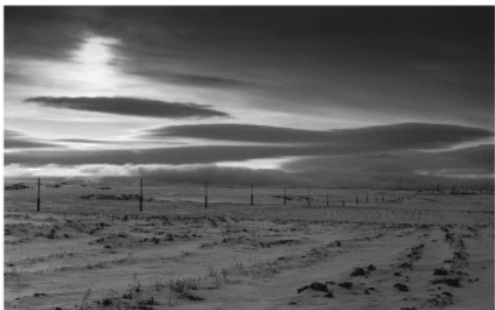
Линия электропередачи от поселка Диксон до г/о «Колба».
