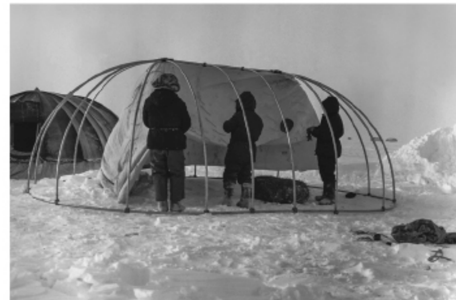
Сборка палатки КАПШ-2 (каркасной арктической палатки Шапошникова).
