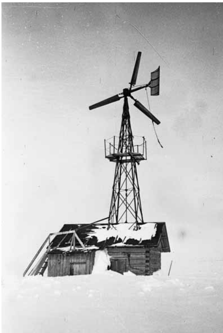
ВЫШКА ВЕТРЯНОГО ДВИГАТЕЛЯ, ОБЕСПЕЧИВАЮЩЕГО НАДЕЖНУЮ РАБОТУ ИЗМЕРИТЕЛЬНЫХ ПРИБОРОВ
