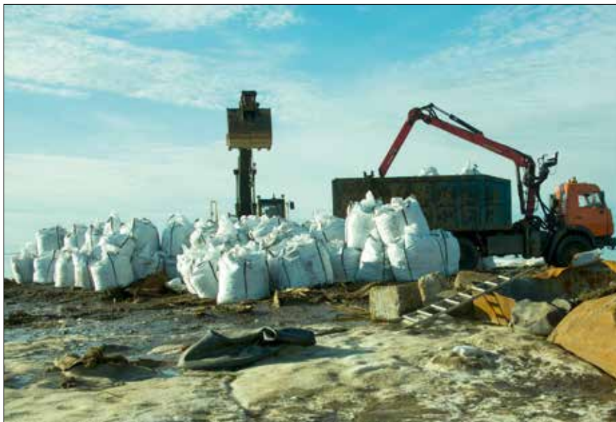
Фото 15. Погрузка собранного угля в мешках биг-бег на металловоз на шасси Камаз на участке «Склад№ 3» (о. Грэм-Белл)
