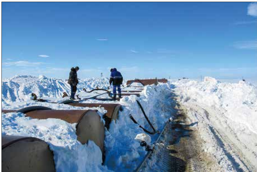
Фото 27. Расчистка резервуаров перед откачкой на о.Греэм Белл (2013 г.)
