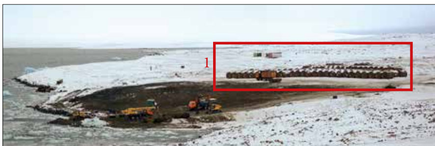
Фото 9. Территория склада ГСМ в Бухте Северной после завершения работ
