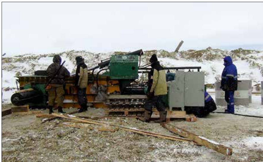
Фото 26. Монтаж оборудования на площадке временного складирования отходов на о.Греэм Белл (2013 г.)
