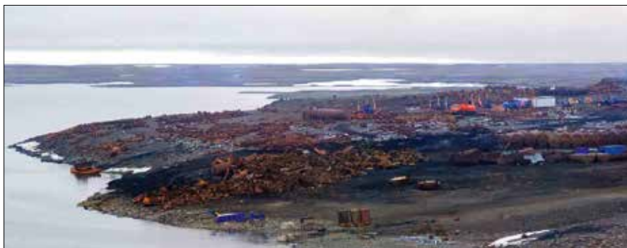
Фото 7. Проведение работ по организации места для размещения площадки временного накопления отходов производства и потребления
