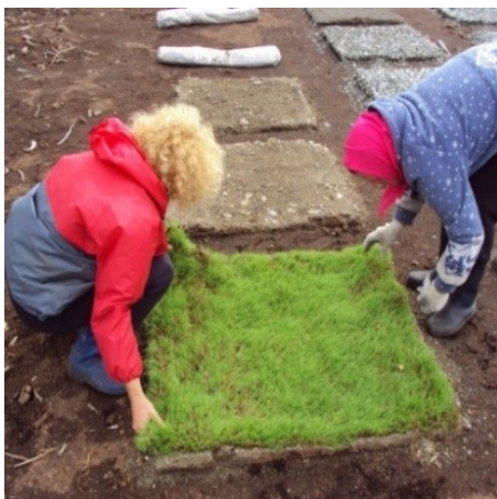
Рис. 35. Формирование растительного покрова настилом ковровой дернины на слой горнопромышленных отходов. Фото Л. Ивановой
